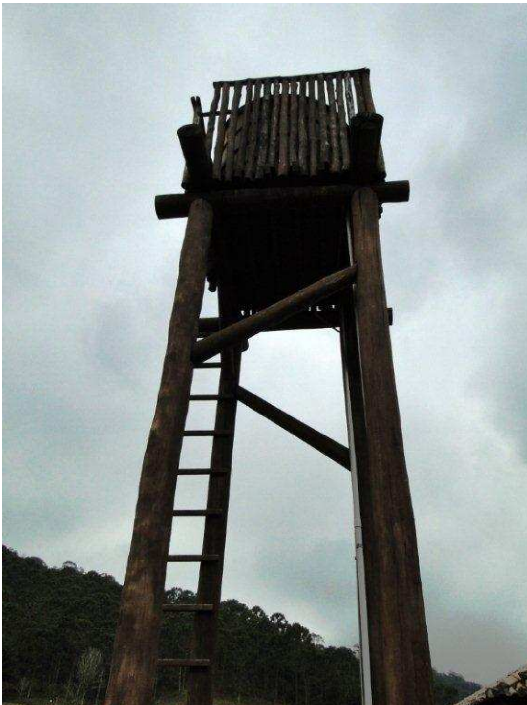
Centro de Visitante de Cunha - Caixa d'Água
